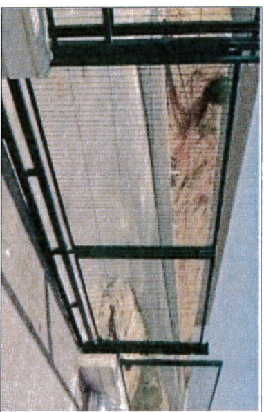
PORTA TANCA DE MALLA ELECTROSOLDADA
