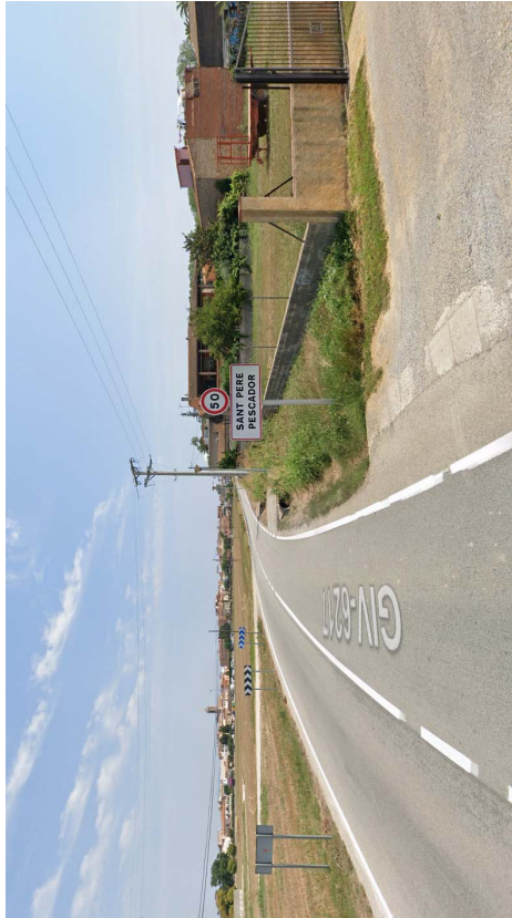
Figura 77. Fotografia estat actual àmbit carretera GIV-6217 dins nucli urbà St. Pere Pescador.
